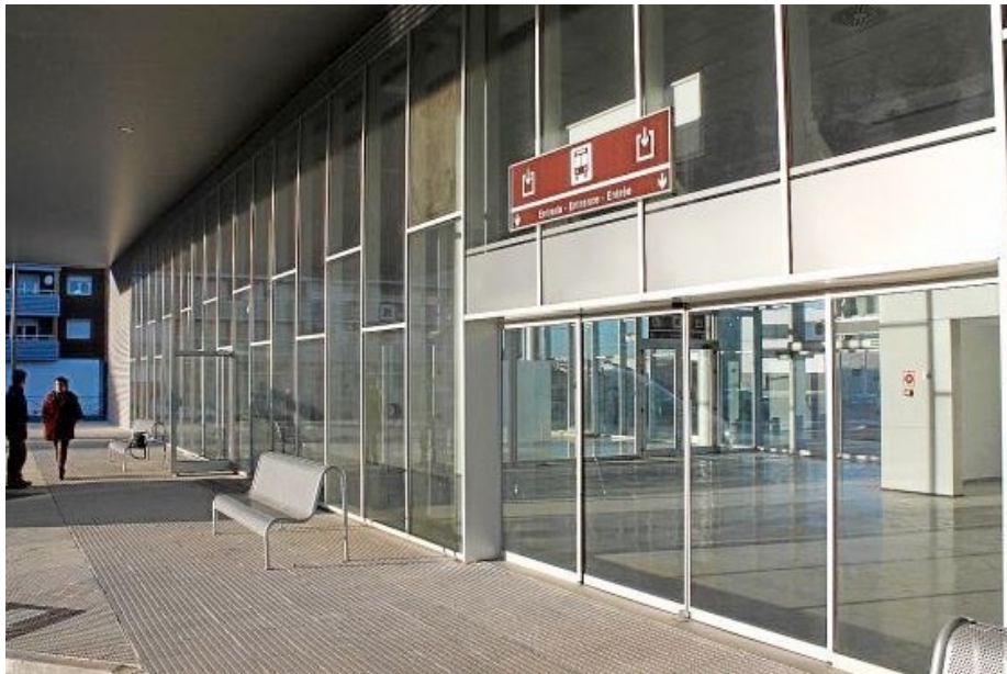
Estación de autobuses de Calamocha
